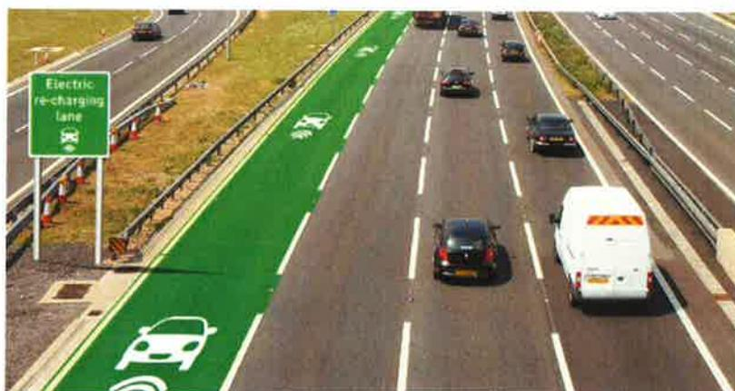
*Figura 6. Carriles de recarga inductiva para coches eléctricos*
