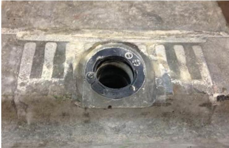
Desgaste producido por la arena del desierto sobre la traviesa de hormigón.
