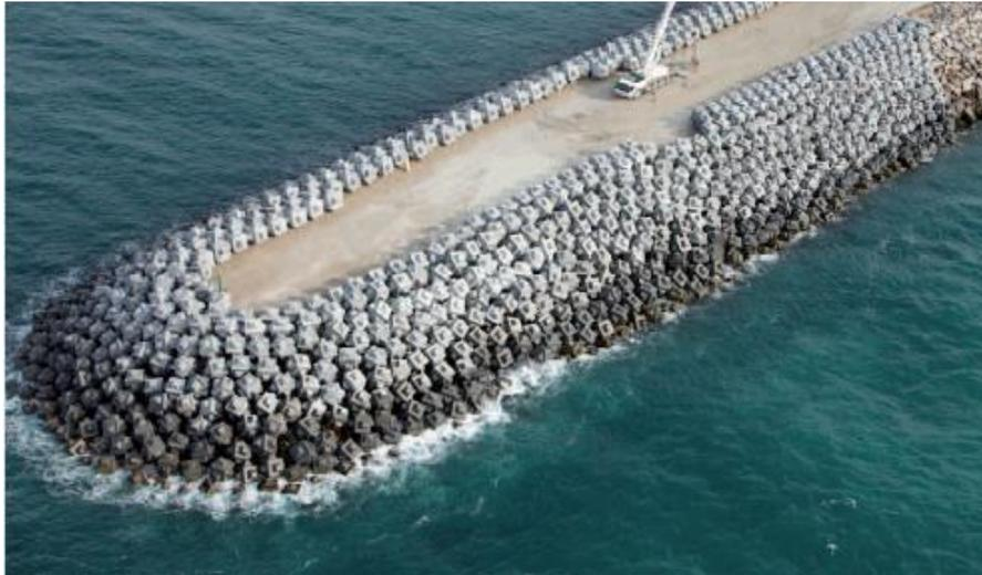
(Dique Sur del Puerto de Langosteira, de 1.350 m de longitud y 22 m de altura de ola, con piezas Cubipod de 25 y 45 toneladas).
